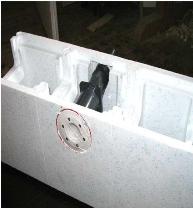
Symbolfotos „Einbau der Mauerdurchführung mit Loch- und Stichsäge“
