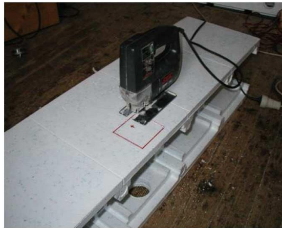
Symbolfotos „Einbau der Mauerdurchführung mit Loch- und Stichsäge“
